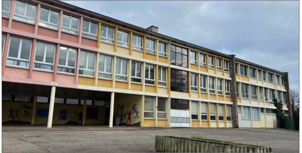
La ville souhaite créer une maison des associations dans l'ancienne école des Vergers. Le bâtiment de trois niveaux pourrait accueillir une vingtaine d'associations. Photo RL/Aurélie KLEIN
