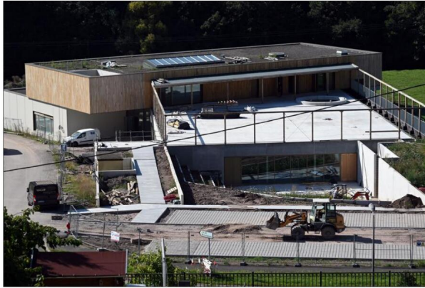
À Maisongoutte, le chantier du groupe scolaire et du pôle périscolaire doit regrouper les élèves des communes de Maisongoutte, Saint-Martin, Breitenbach et Steige. Photos DNA/Franck DELHOMME
